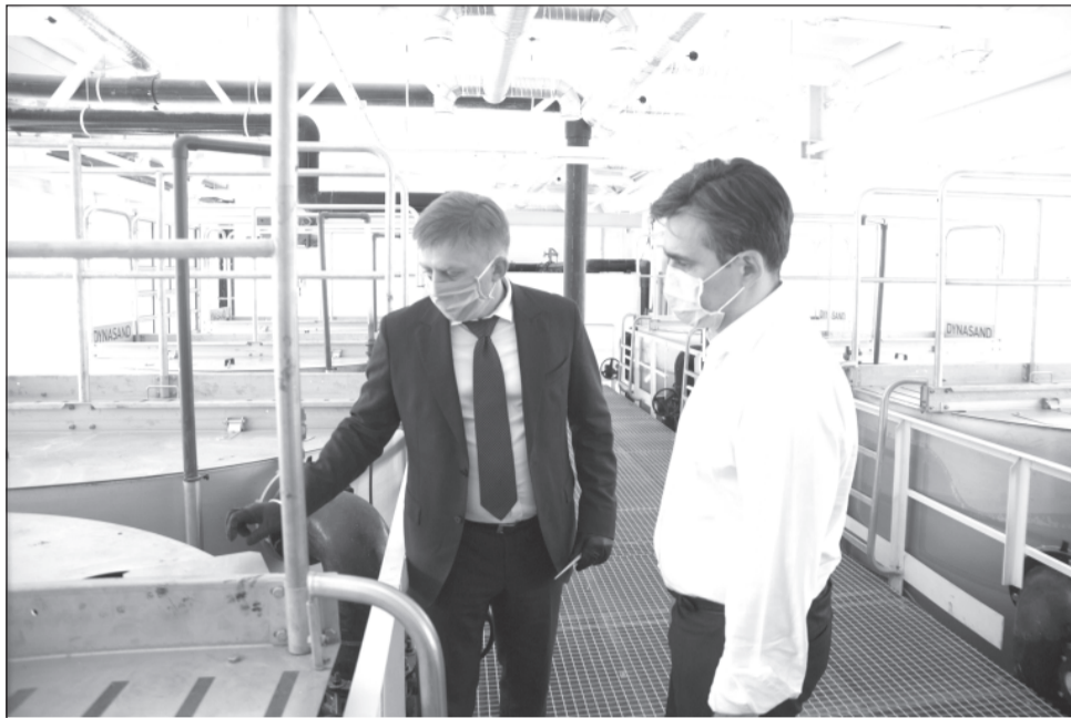
Гендиректор АО «Водоканал» Александр Морозов и губернатор области Станислав Воскресенский на станции обезжелезивания. Объект находится в стадии пуска-наладки, но чистая вода уже начала поступать в дома приволжан. Фото Д. Рыжакова
